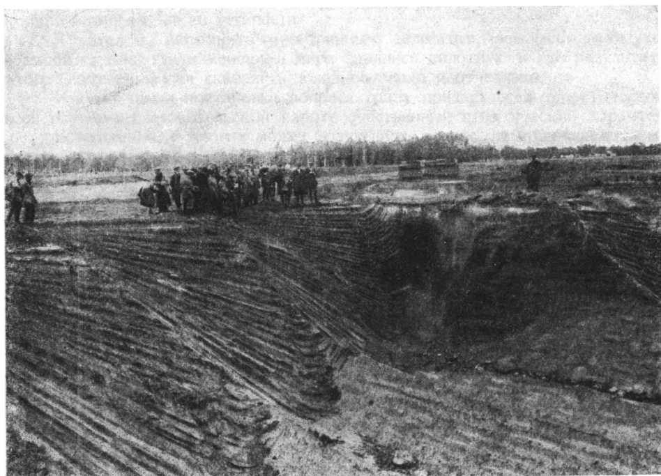
Москва. Одинцово. Кирпичный завод. Экскаваторные выработки. Карманы верхней морены в межледниковых глинах.
