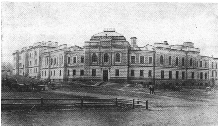
Здание Горного отделения Томского технологического института (угол б. Бульварной и Еланской улиц).
