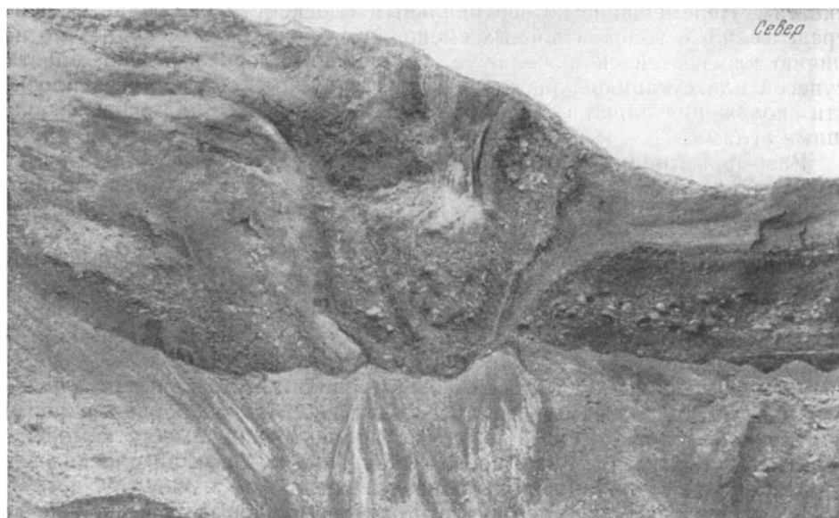
Рис. 2. Расширяющаяся вверх трещина, заполненная валунно-гравийным материалом
