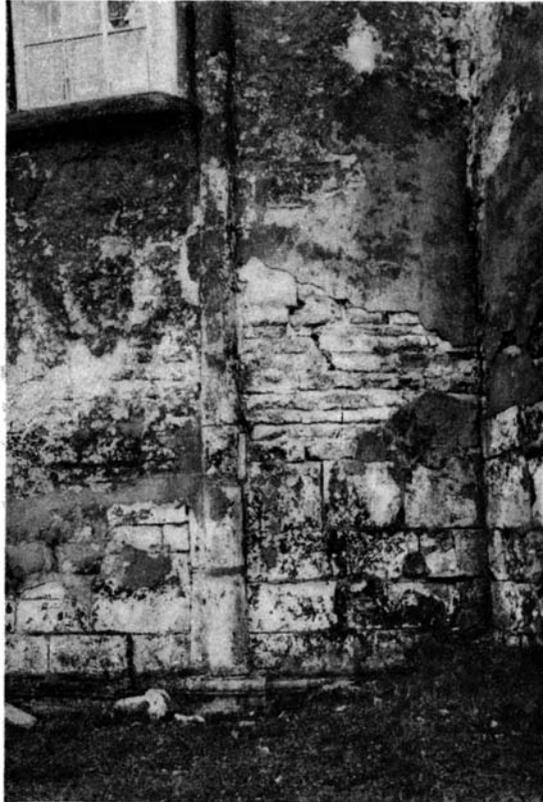
Фиг. 2. Суздаль. Рождественский собор. Восточная стена у абсид, со следами морозного разрушения. Сложена известняками в нижней части и известковыми туфами в верхней части
