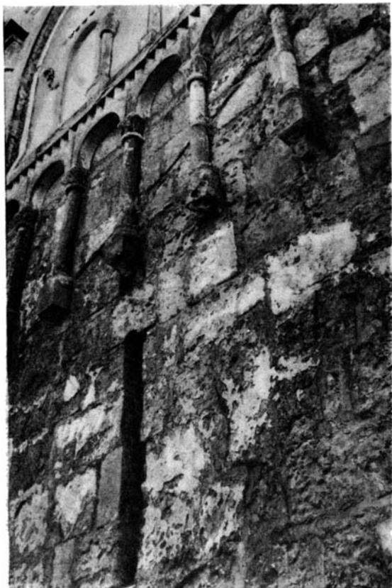
Фиг. 5. Боголюбово. Палаты Андрея Боголюбского. Западная стена. В левой верхней части стены четко видны границы прилегания крыши пристройки, снесенной при реставрации в 1944 г.
