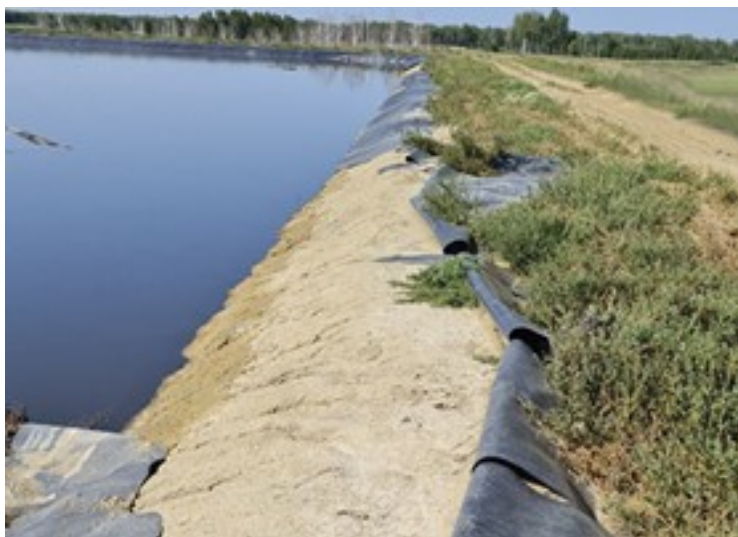
Рис. 1. Разрыв геомембраны
